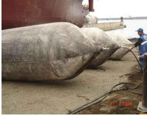
Şekil 7. Balonların şişirilmesi ve kontrolü
